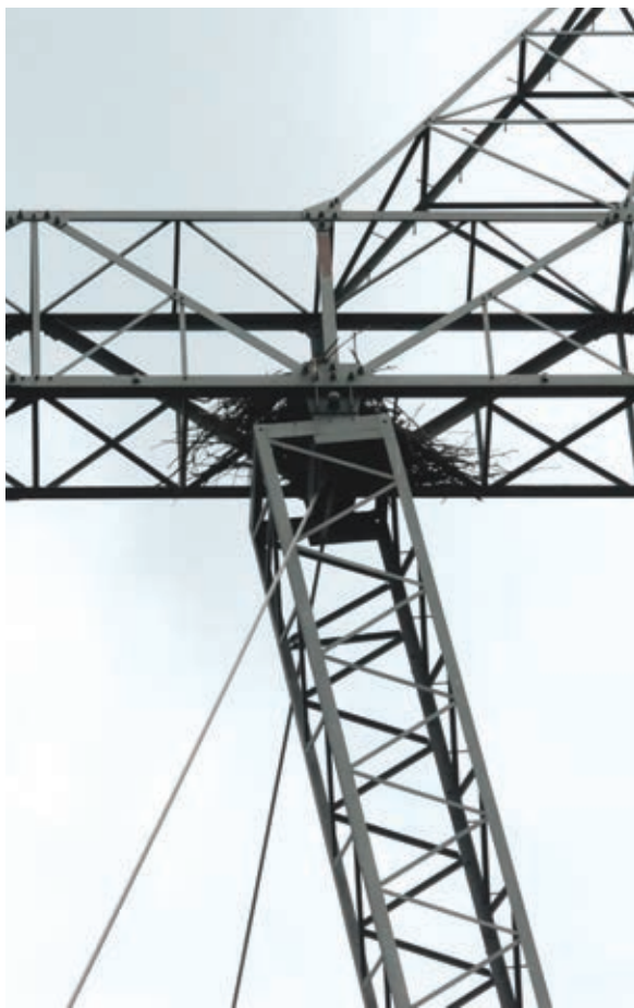
3. ábra: Félig kész parlagisas-fészek a Nagyunságban, 2015 májusában (fotó: Bagyura János) / Half-prepared Eastern Imperial Eagle nest on high-voltage electric pylon in the Nagyunság in May 2015
